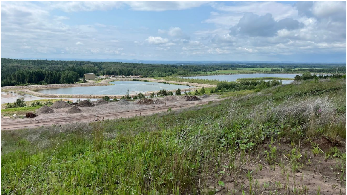
Une vue d'ensemble du bassin 6 et 8.
