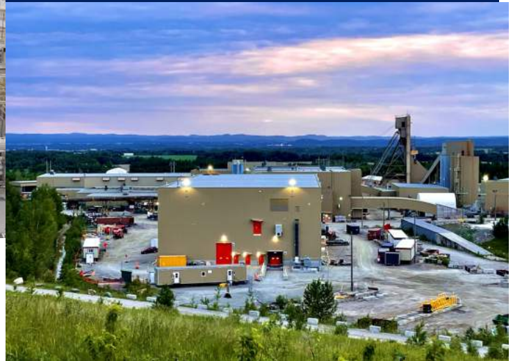
Usine de traitement d'eau de mine (vue du parc à résidus) – Mai
