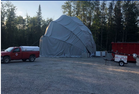
Environnement de travail – Dôme cotenant la foreuse
